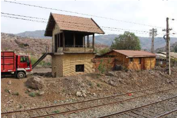
Imagen 15. Estación de ferrocarriles de Enrique Meiggs.
