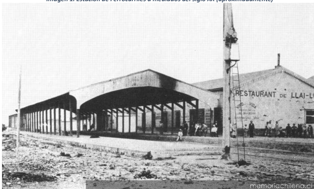
Imagen 1. Estación de Ferrocarriles a mediados del siglo XX (aproximadamente)
